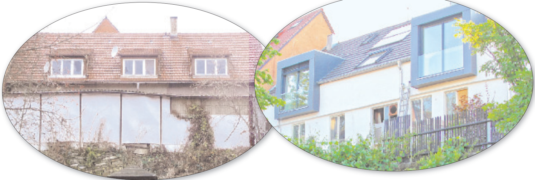
Vorher und nachher: Die Energiediagnose des EBZ stand am Anfang. Inzwischen ist der 50er-Jahre Bau ein technisch neuwertiges Effizienzhaus. Fotos: raum plan GmbH
